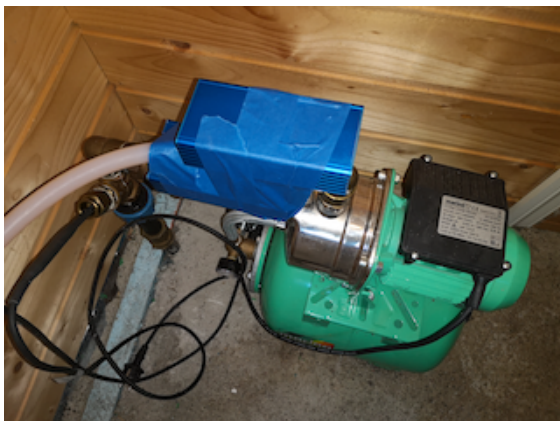
Figur 3. Pumpe som henter opp vann fra brønn som stammer fra taket på hytten på Træenstølen. To enheter DBV-2 ble fastlimt på inngangsrøret fra brønnen og utgangsrøret for fordelingen inn i de ulike rom i hytten.
